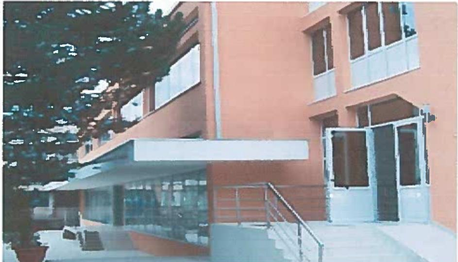
Aceasta structura a fost asezata pe capul stâlpilor de beton armat existenti ai magazinului cu regim de inaltime parter.
